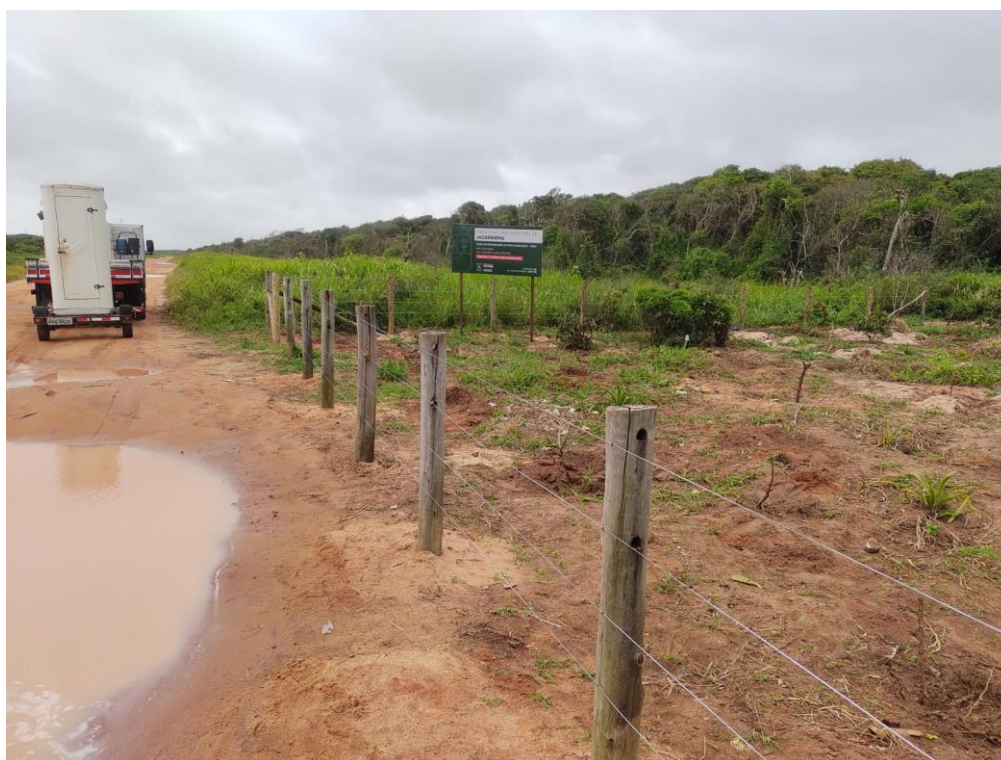
Figura 7 - Instalação de cerca na área de recuperação do “Valão” do Parque N. M.de Jacarenema, com mourões de eucalipto tratado, roliços, com 2,20 metros de comprimento e diâmetro de 15 – 20 cm, com quatro fios.
