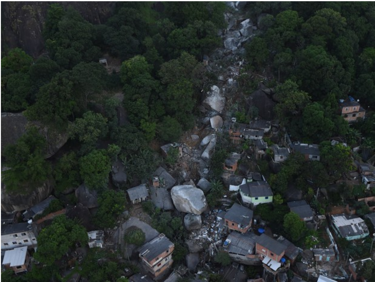
Deslizamento de rocha. Morro Boa Vista – São Torquato – 2016. Crédito: Fred Loureiro.
